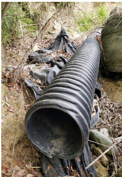
図2 実際に調査した雨水管
