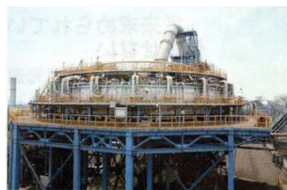
新製鉄法(FASTMET)を採用したプラント Tsutsumi et al. KOBE STEEL ENG. REPORT, 60, 1-36.
