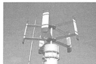
図4 直線翼垂直軸風車
