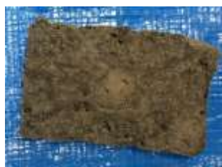
[fig.34] 再固化コンクリート
